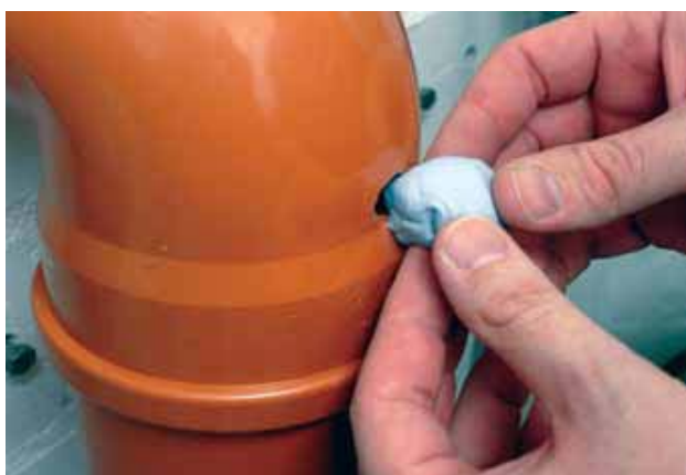
Riparazione di un tubo in PVC
